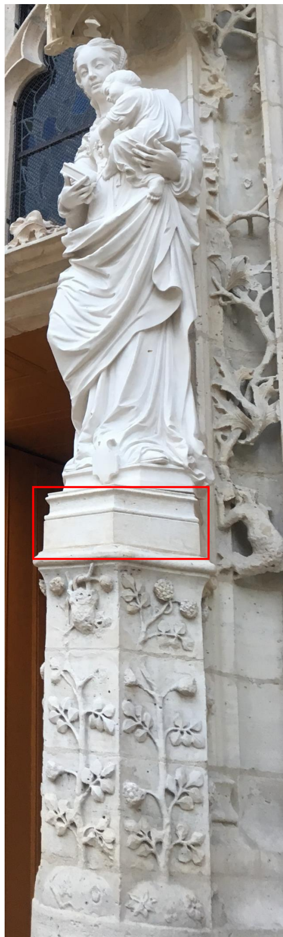
Le trumeau de la façade occidentale de l'église après les travaux de 2019, avec un nouveau socle de substitution.
