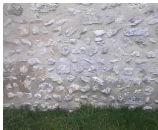
Appareillage en opus spicatum dans le mur gouttereau sud de l'église d'Ecuelles
