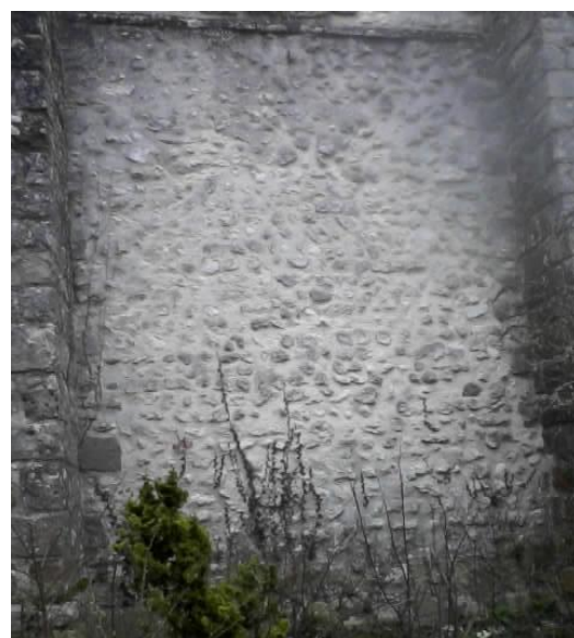
Appareillage en opus spicatum dans le mur gouttereau sud de l'église d'Ecuelles
