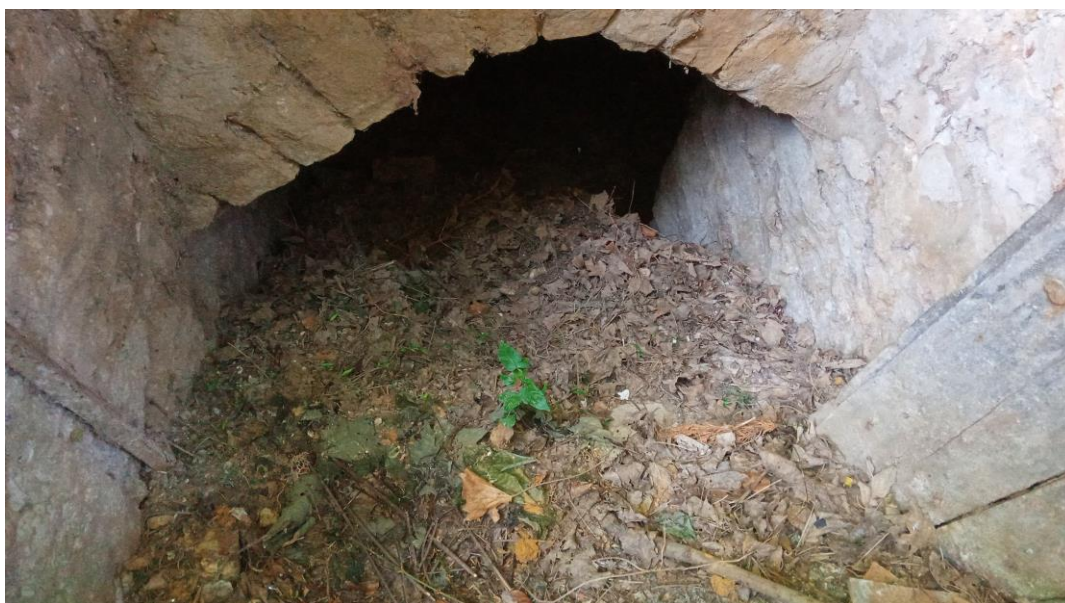
La voûte d'accès à la cave
